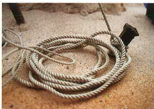
Eingeschlagener Pflock mit Seil zur Abspannung des Dreibocks
